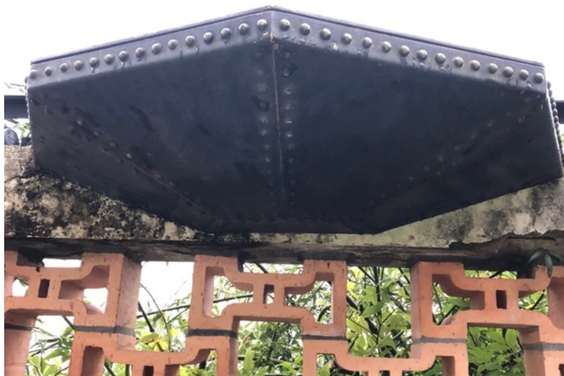
Fig. 3 : Le support métallique vue d'en dessous.
